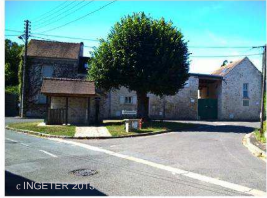
Espace résiduel, croisement de la Rue des Sablons et de la Rue Abraham (2) : « Place du Tilleul »
