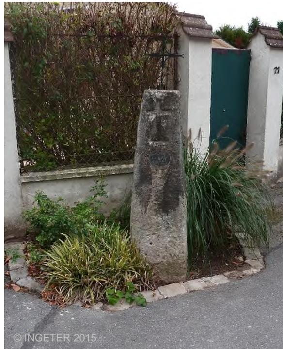
Figure 90: Borne d'arpentage
